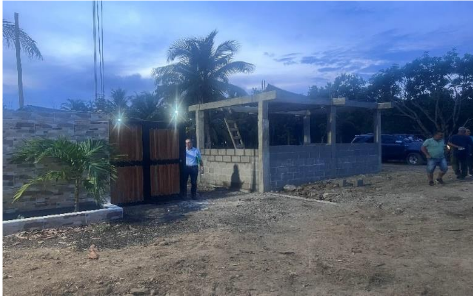
Área de “recepción y registro” – Entrada al Centro de Atención (40% avanzada en su construcción), Junio 13 de 2023
