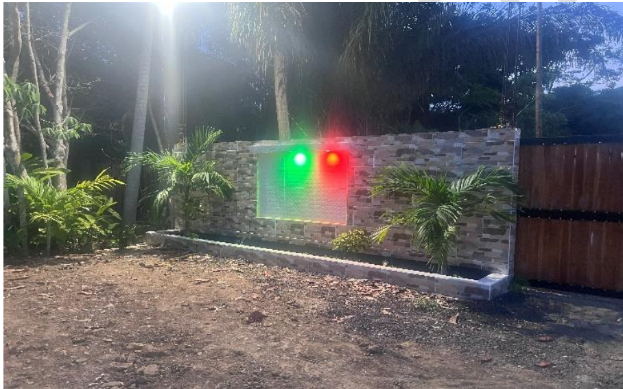
Avance construcción fachada del Centro de Atención (80% concluida), Junio 13 de 2023.
